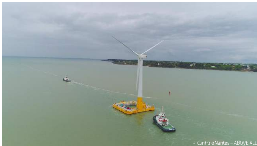
FIGURE 10 : REMORQUAGE DE L'ÉOLIENNE JUSQU'AU SITE SEM-REV.
