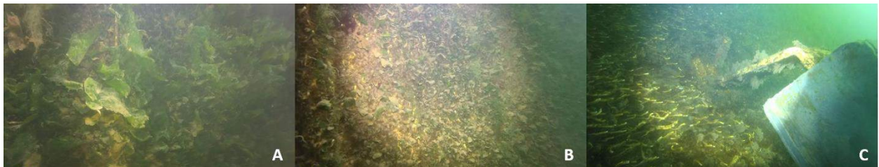
FIGURE 40 : BIOLONISATION DU FLOTTEUR FLOATGEN 4 MOIS APRES SA MISE A LEAU DANS LE PORT DE SAINT-NAZAIRE (PROSPECTION FAITES EN NOVEMBRE 2017, CN – SEM-REV).
