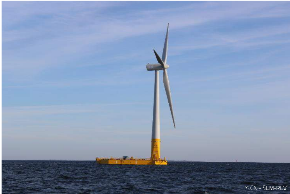
FIGURE 4 : L'ÉOLIENNE FLOATGEN (BW IDEOL) SUR LE SITE D'ESSAIS SEM-REV.
