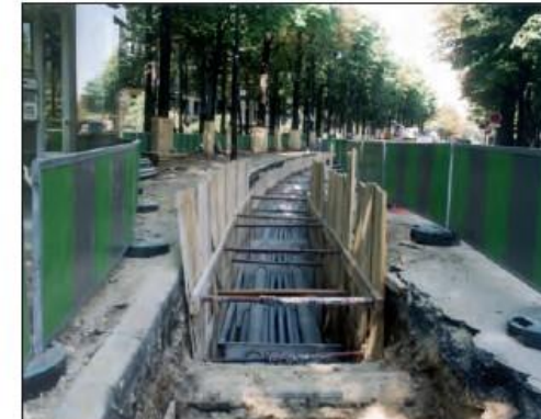
Tranchée de pose de câbles en fourreaux PVC
