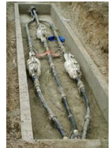
Chantier par tronçon (avec chambre de jonction)
