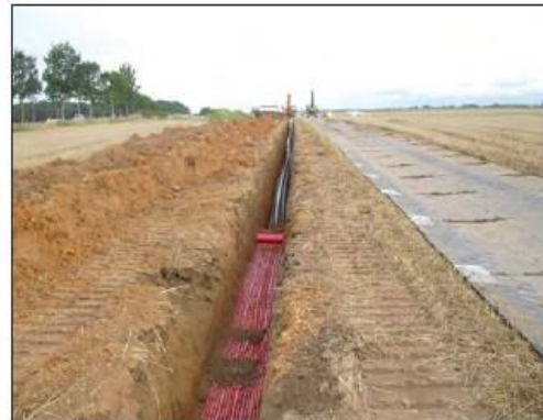
Pose de fourreaux PEHD en pleine terre
