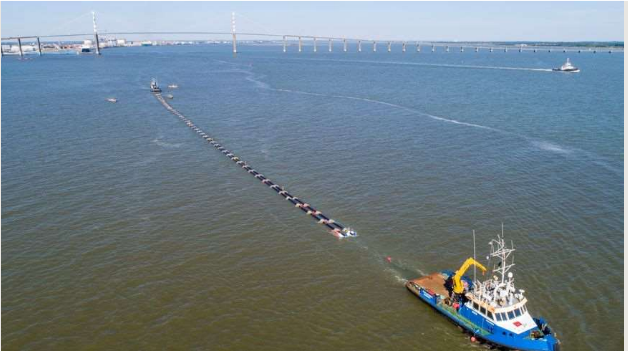
Illustration : remorquage conduites flottées crédits : RTE / Valery Joncheray
