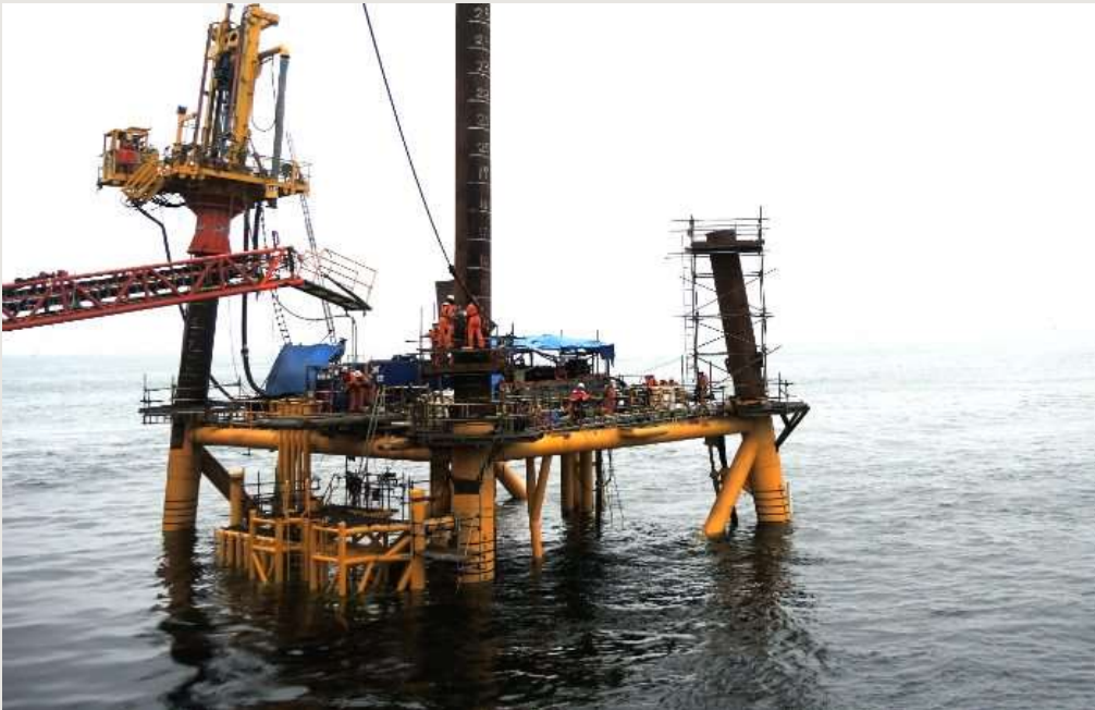
Installation de fondations
