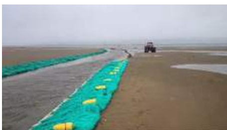
Des filets pour lutter contre l'érosion du littoral
