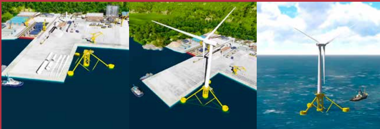
Illustration des étapes du montage de l'éolienne et de son installation en mer.
