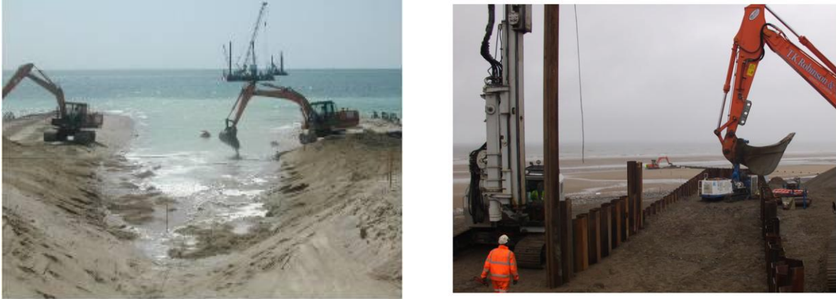
Figure 19 : exemple de tranchée ouverte sur la plage
