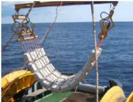
Figure 10 : exemple de protection externe par matelas
