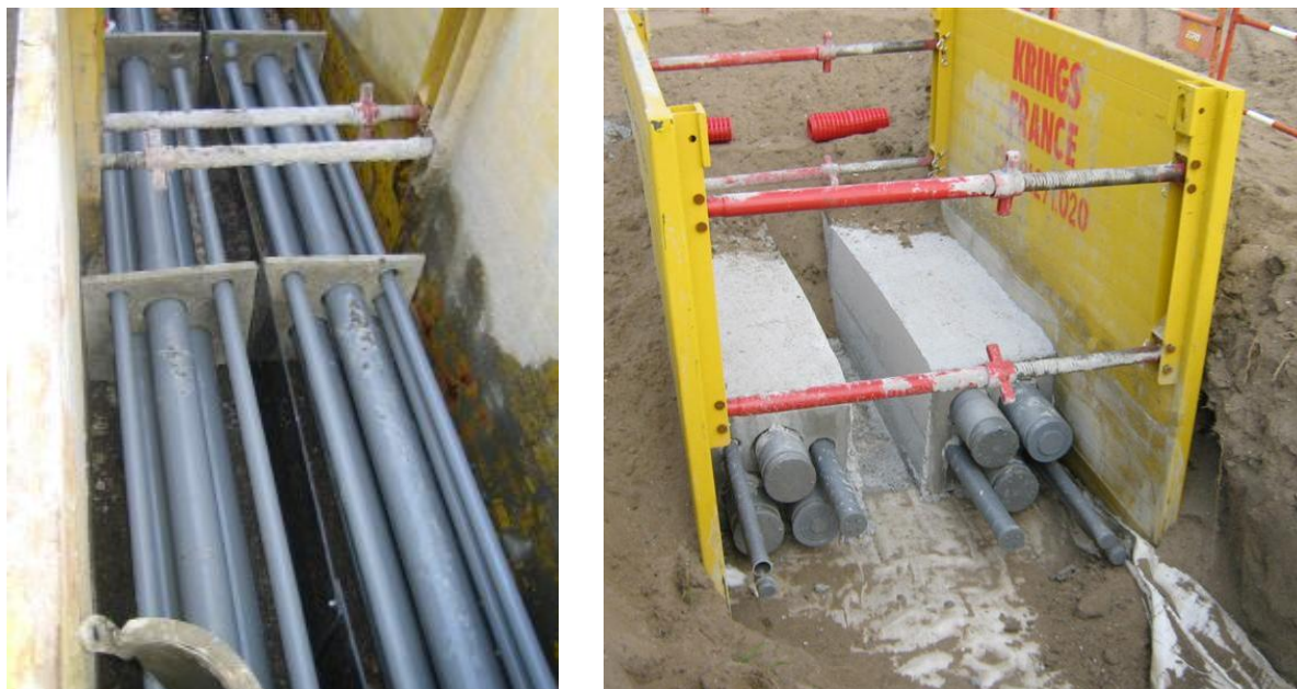
Figure 27 : illustration d'une liaison souterraine à deux circuits
