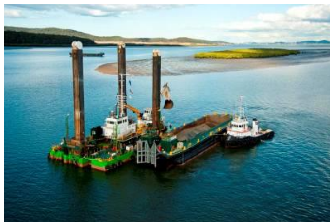
Figure 16 : exemple de pelle rétro-caveuse, ici avec navire sablier et remorqueur
