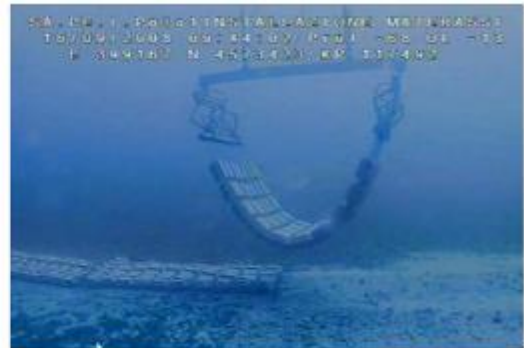
Figure 10 : exemple de protection externe par matelas
