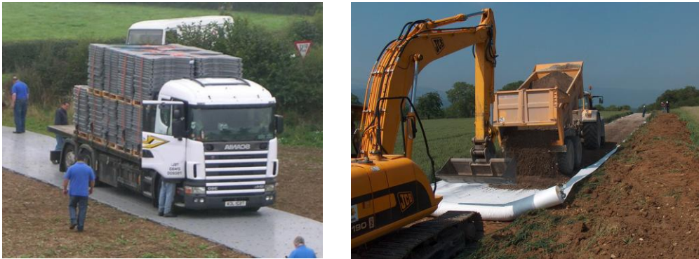
Figure 34 : exemples de pistes en « plaques » et en matériaux
