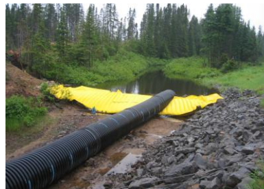
Figure 32 : exemples de batardeaux provisoires
