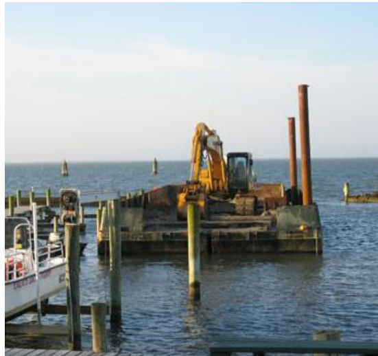
Figure 17 : exemple de pelle mécanique sur barge autoélevatrice
