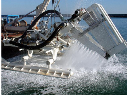
Figure 15 : exemple de water jetting
