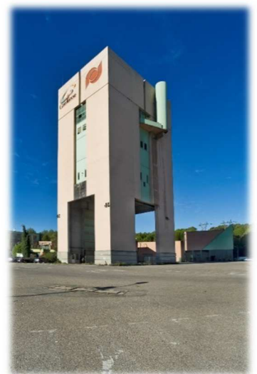
Ancien carreau de mine avec le chevalement béton du puits Morandat qui deviendra la future ZAC exploitant le potentiel géothermique des eaux de mines. © BRGM
