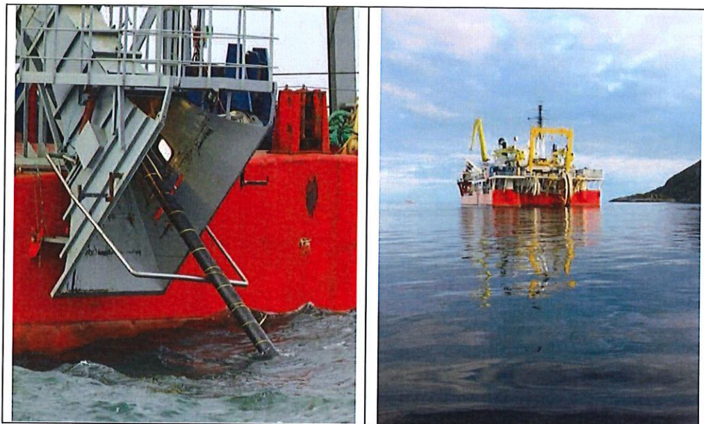
Photo 6 : pose d'un câble sous-marin par un navire câblé
