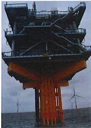
Photo 1 : exemple d'une sous-station électrique en mer
