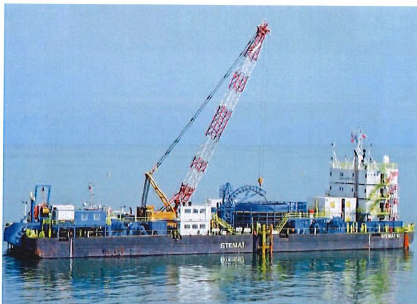
Photo 7 : barge posant des câbles
