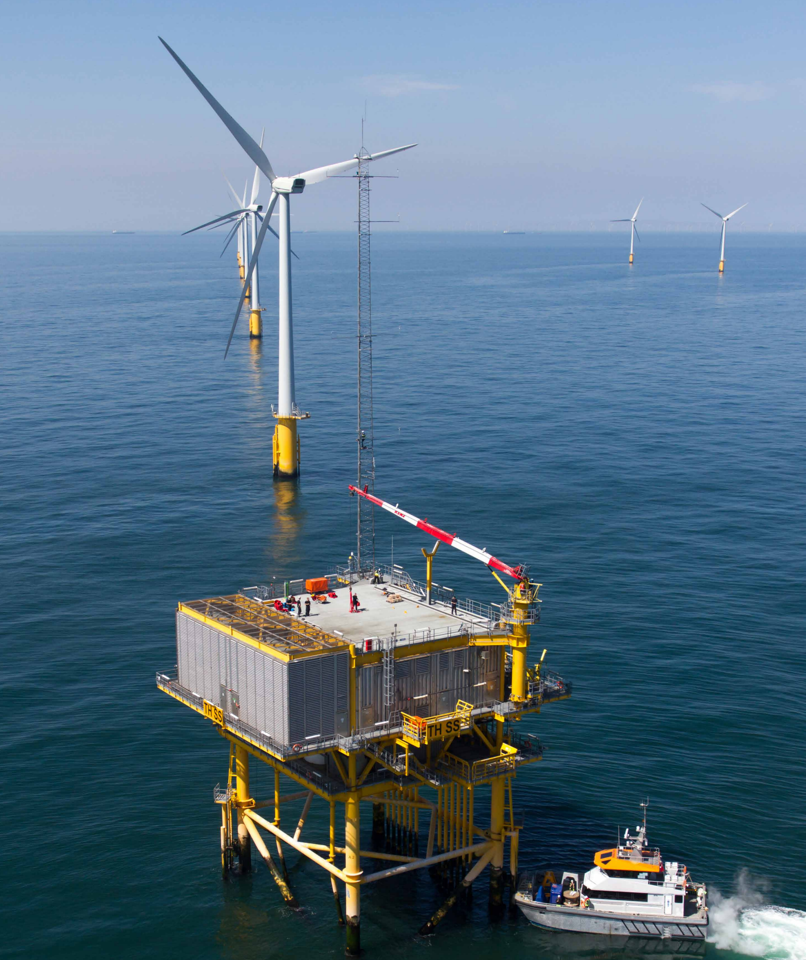
Thanet Offshore Wind Farm — Courtesy Vattenfall
