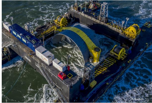
Mise à l'eau de l'hydrolienne d'OpenHydro dans la baie de Fundy (Canada), en 2016
