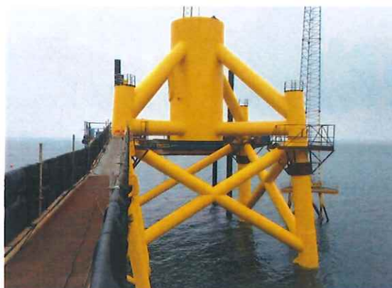
Figure 7 : Exemple d'une pièce de transition
