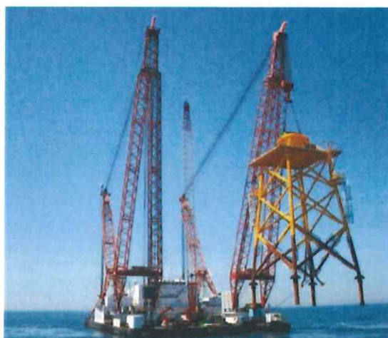
Figure 16 : Installation d'une fondation jacket (source : IHC, 2016)
