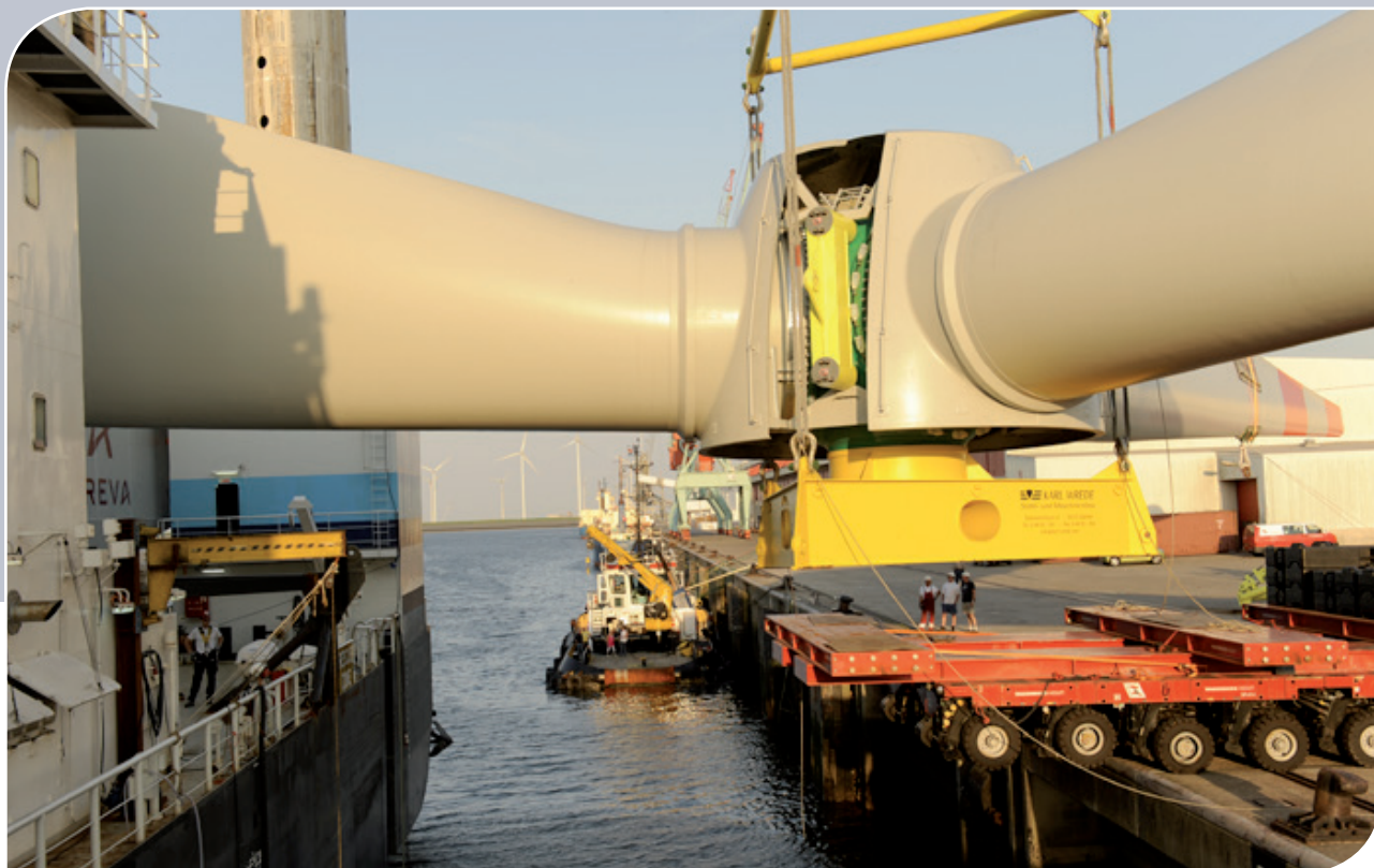
Installation d'éoliennes - Adwen - Allemagne
