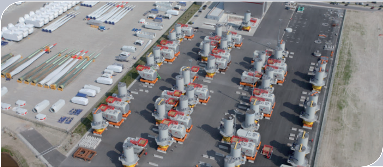
Usine Adwen à Bremerhaven, Allemagne
