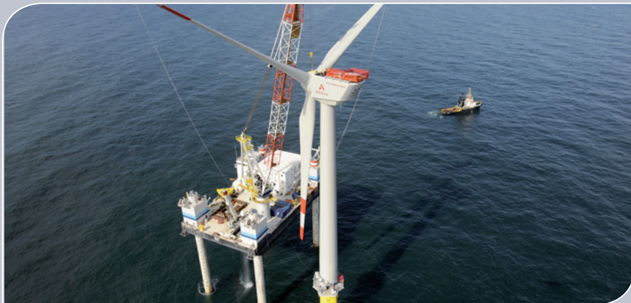
Installation d'éoliennes - Adwen - Allemagne
